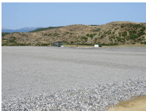
Image 27: Couche de drainage réalisée (avec renforcement au niveau des conduites)
