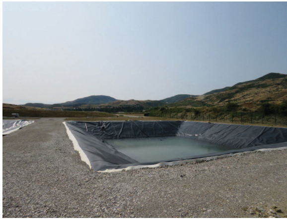
Image 5: Exemple d'un bassin de stockage des lixiviats
