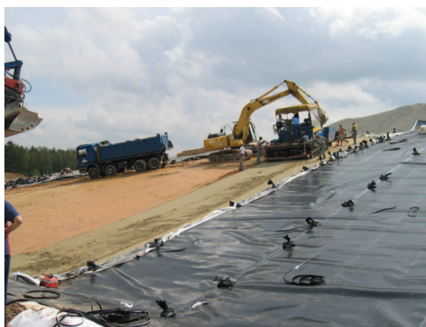
Image 24: lestage de la géo-membrane et préparation du chevauchement
