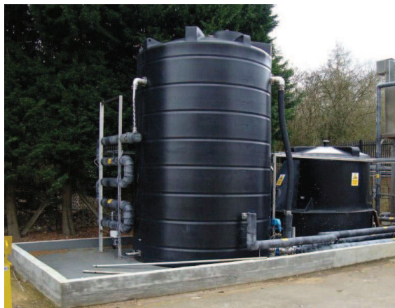
Image 4: Exemple de citernes de stockage temporaires des lixiviats
