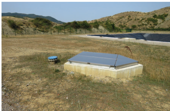
Image 8: regards de contrôle réalisés conforme aux plans d'APD
