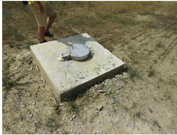
Image 6: Puits d'observation/piézomètre (couvercle)
