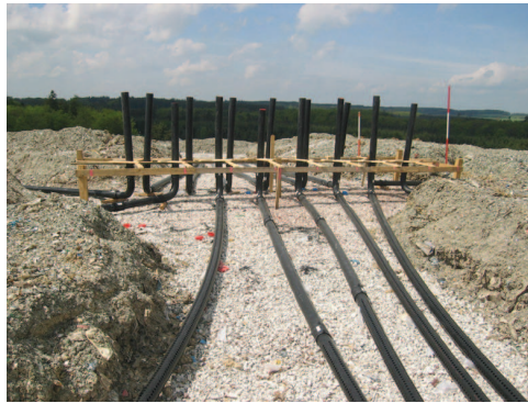
Image 7: mise en place d'un réseau de collecteurs horizontaux
